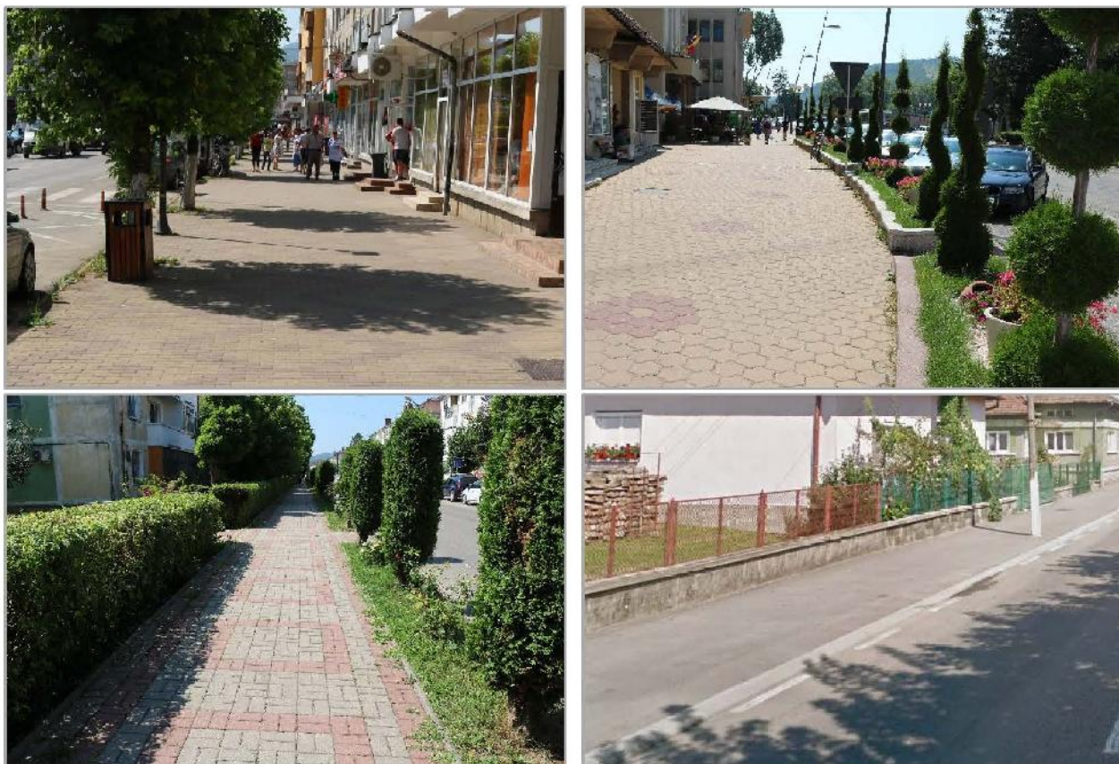
Figura 2.45. Trotuare în stare bună (Exemplificare).
